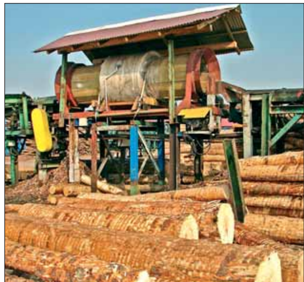
Stanowisko wyłapywania metalu na linii manipulacji
