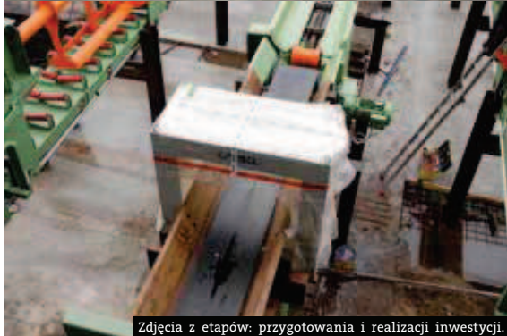
Zdjęcia z etapów: przygotowania i realizacji inwestycji. Fot. Jacek Kubiak
